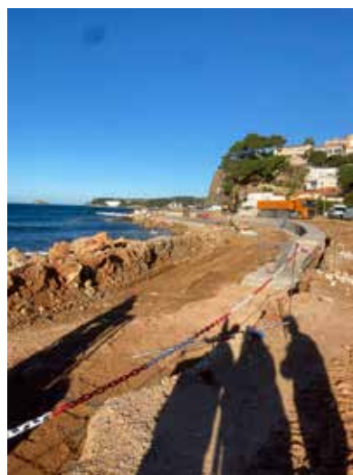
Le chantier du talus début novembre 2025 (pose des gabions)
