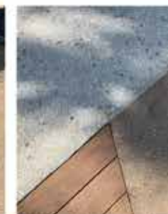
Joints de calepinage et alcove
